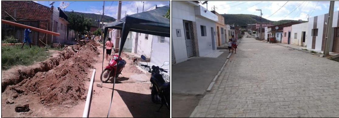
Rua Amaro Monteiro no Bairro Trevo recebendo obra de saneamento logo após o calçamento concluído.
