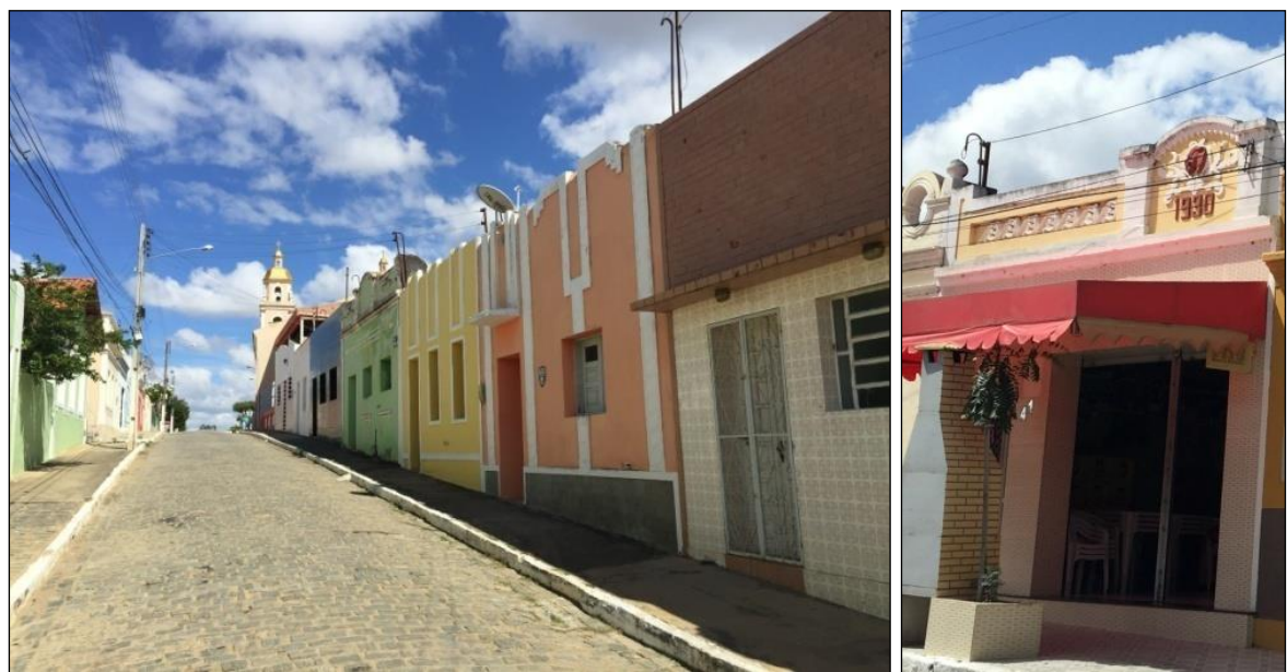
Patrimônio Arquitetônico Local e exemplo de reforma parcial de fachada
