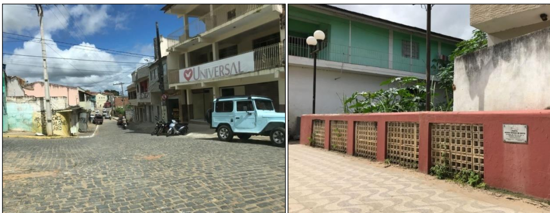
Aspecto da Rua Maria Ferraz de Brito, Bairro Brasília
