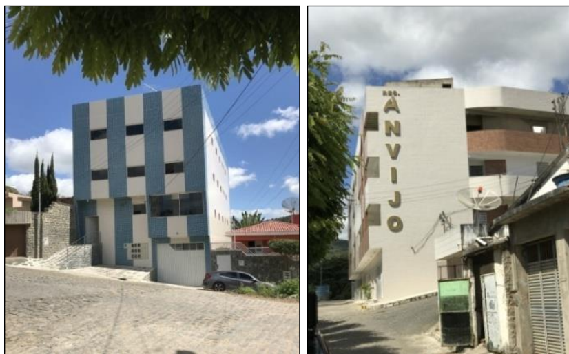
Rua José Holanda e Silva com edificações com vários pavimentos
