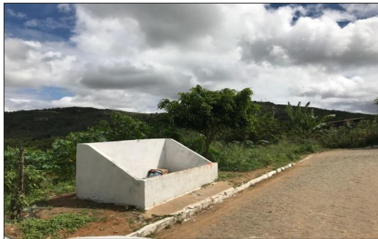
Lixeira de Alvenaria Rua travessa a Rua Padre Pedro no Capibaribe
