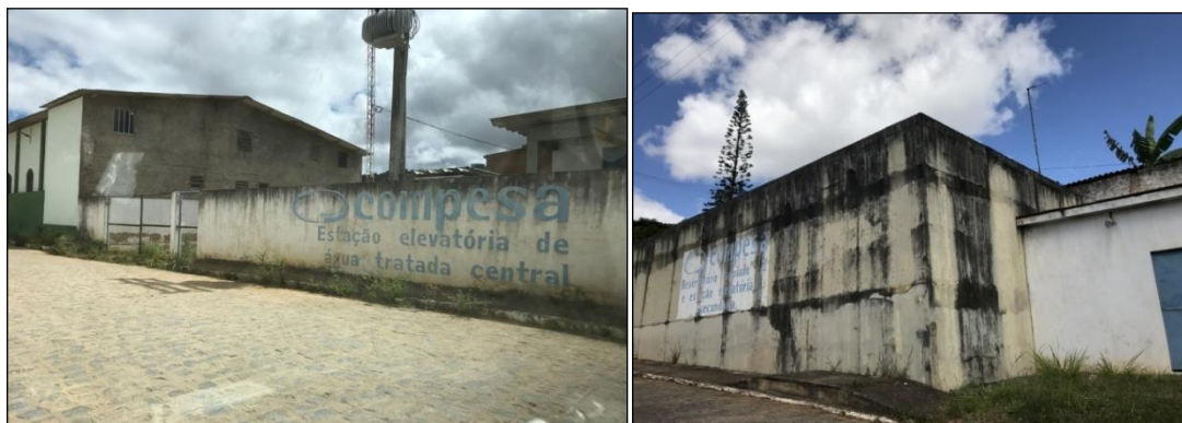
COMPESA e reservatório próximo a prefeitura
