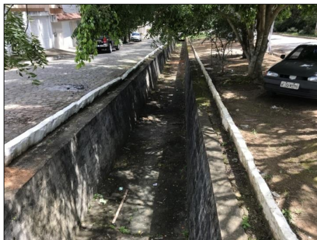
Canal aberto do Açude Santo Amaro
