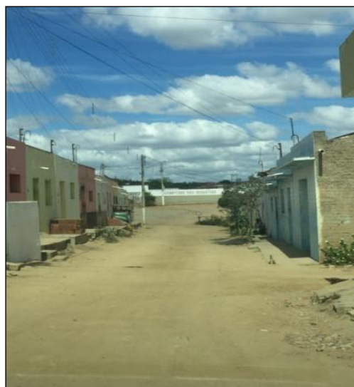
Rua de acesso ao cemitério sem pavimentação
