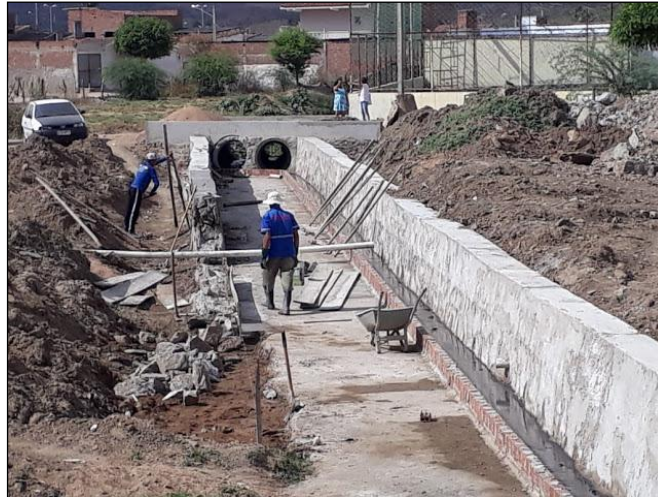
Obra da passagem da Rua Gerson Juventino e a obra do canal de Pão de Açúcar esta em construção
