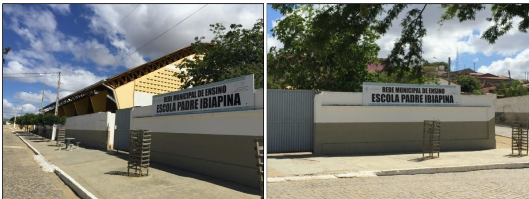
Fachada da escola municipal
